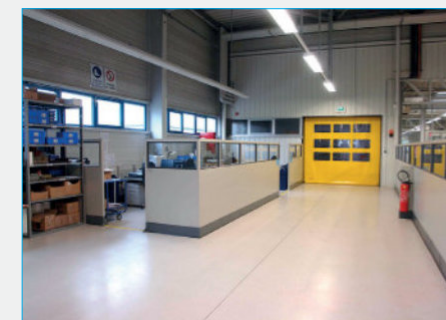
halbhohe Stellwand als Fahrwegabtrennung
