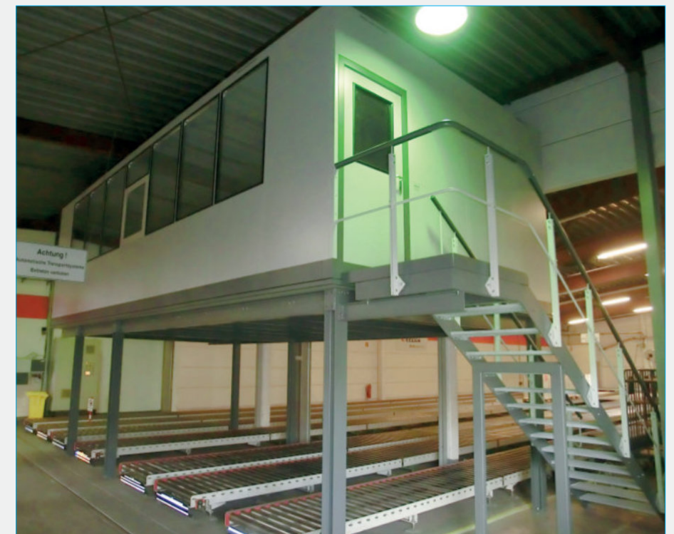
Schallschuttkabine: sperrt störenden Lärm ein
