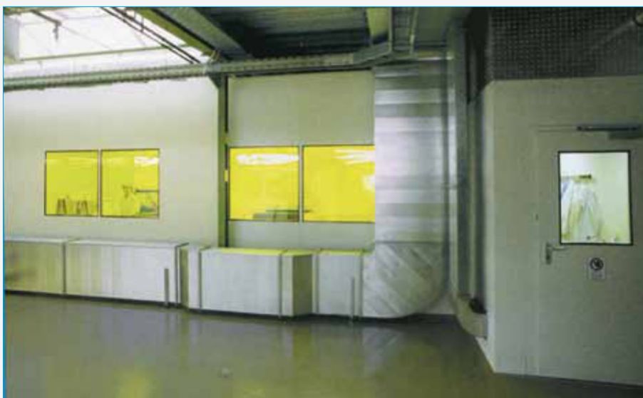
In die Wand integrierte Anlagentechnik
