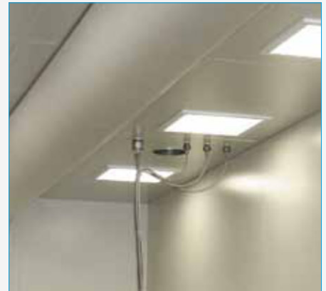
Die praktische Lösung: das Medienpaneel in der Reinraumdecke
