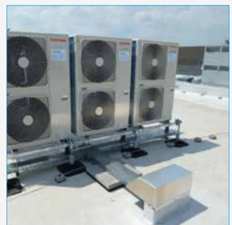
Modulare Klimakonzepte mit redundanter Kälterzeugung
