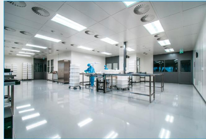
**Im Reinraum nach DIN EN ISO 14644-1 werden Partikel bis 5 µm überwacht und auch Mikroorganismen.**
