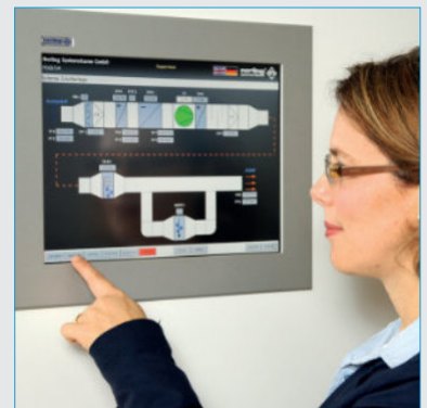
Die zentrale Raumsteuerung über Touchpanel
